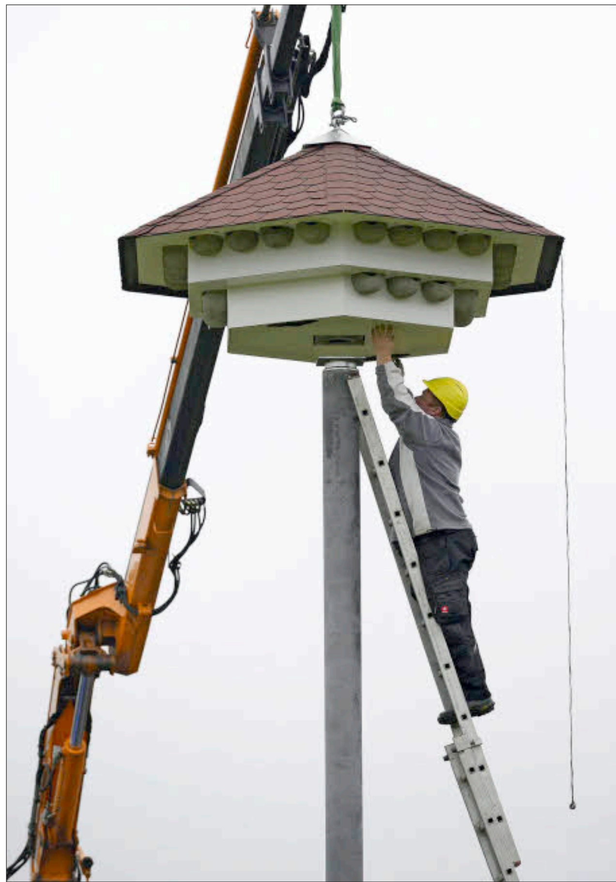
Maßarbeit war gestern bei der Installation des Schwalbenhauses neben dem Stadtteil Rieselfeld gefragt.
